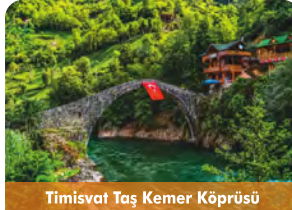
Timişvat Taş Kemer Köprüsü
