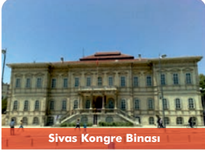
Sivas Kongre Binası
